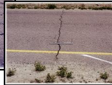
Thermal Cracking
